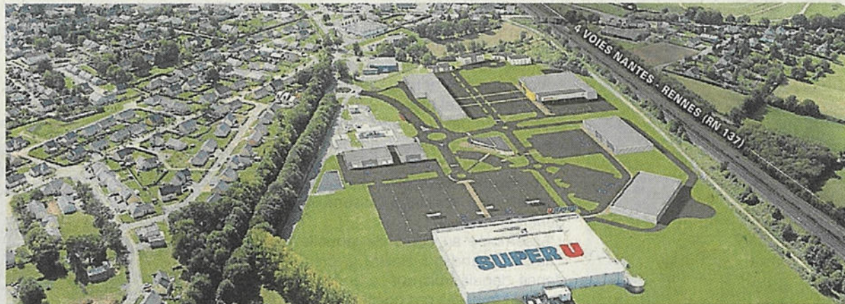
Une zone commerciale de quatorze hectares à proximité de la quatre voies Nantes-Rennes.
